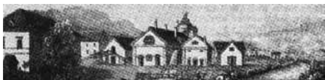
Litografía de la fundición de hierro en Brückl de 1855
